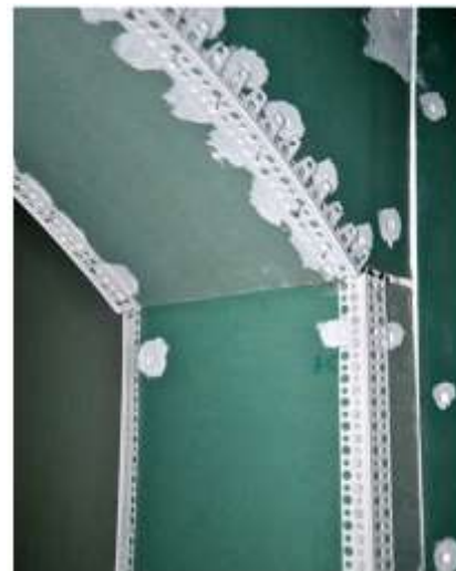
Figura 44. Fixarea profilurilor de colț
