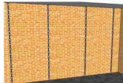
Figura 43. Fixarea reperelor pe suprafață
