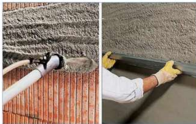
Figura 51. Tencuirea suprafețelor în mod mecanizat.
