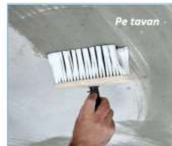
Figura 41. Amorsarea suprafețelor
