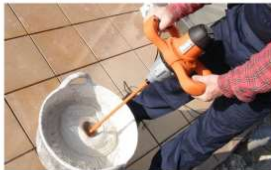
Figura 40. Prepararea mortarului cu malaxorul
