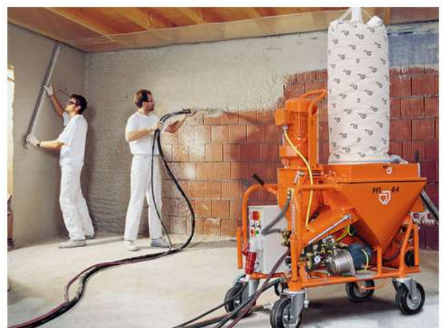
Figura 53. Procesul de tencuire cu mașina de tencuit
