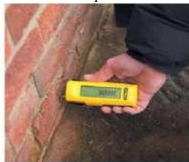
Figura 18 Verificarea umidității suprafeței cu umidimetru.
