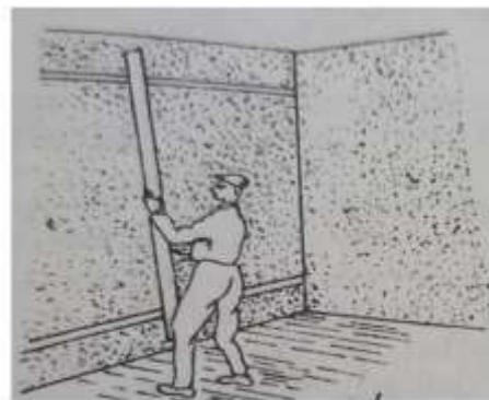
Figura 23. Executarea fâșii de mortar orizontal
