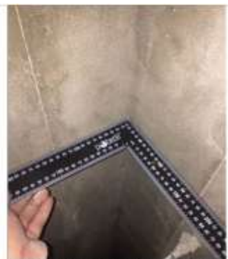
Figura 30. Verificarea colțului interior de 90°
